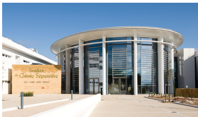
Institut de Chimie Séparative de Marcoule Fondation FRE 2629 CEA/CNRS/UM et ENSCM en 2004, ouverture des laboratoires en 2010, et direction de l'ICSM jusqu'en 2015
